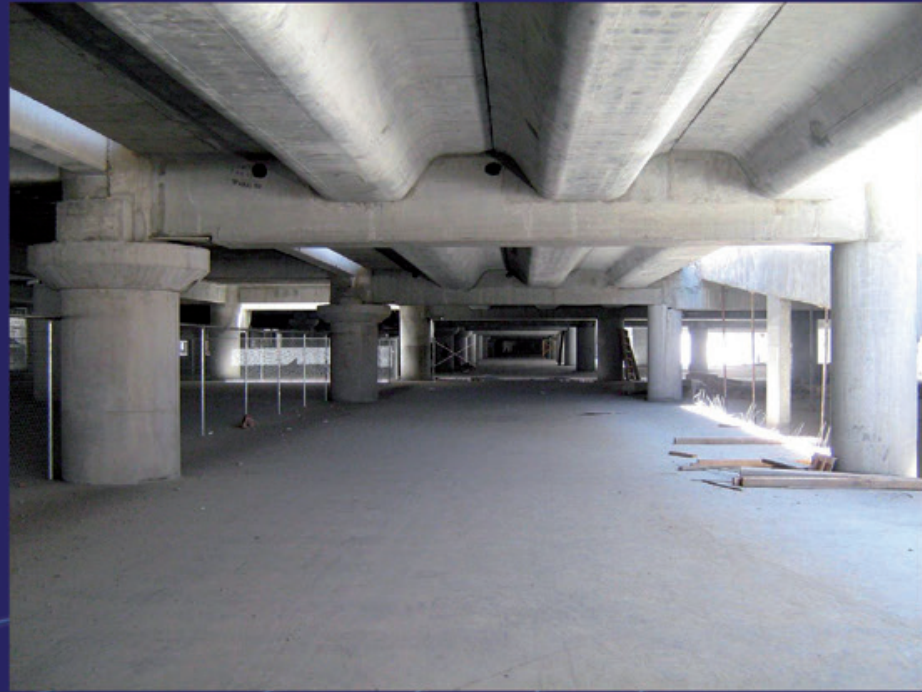
Centro Comercial Andares, Zapopan Jalisco. Elemento estructural Omega. Grandes claros, limpieza en la obra, rapidez en su ejecución.
