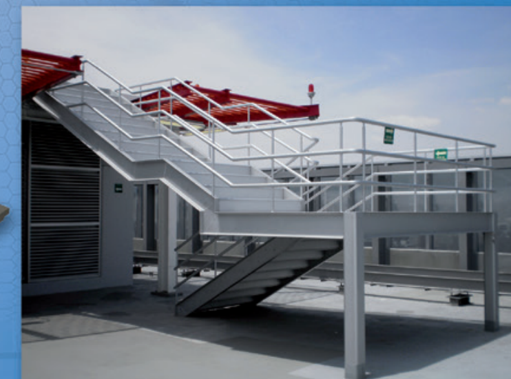
Escaleras Metálicas para Helipuertos en Plaza Carso.
