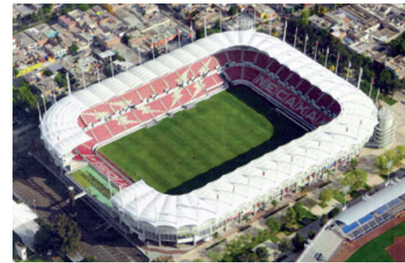
Estadio Victoria, Aguascalientes
