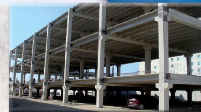
Columnas, Traveses y Losas TT
