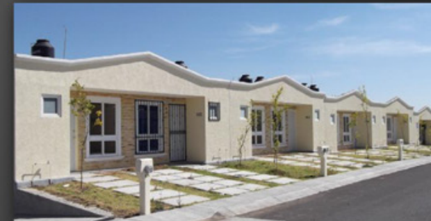
Conjunto habitacional «La Hacienda». Morelia Michoacán
