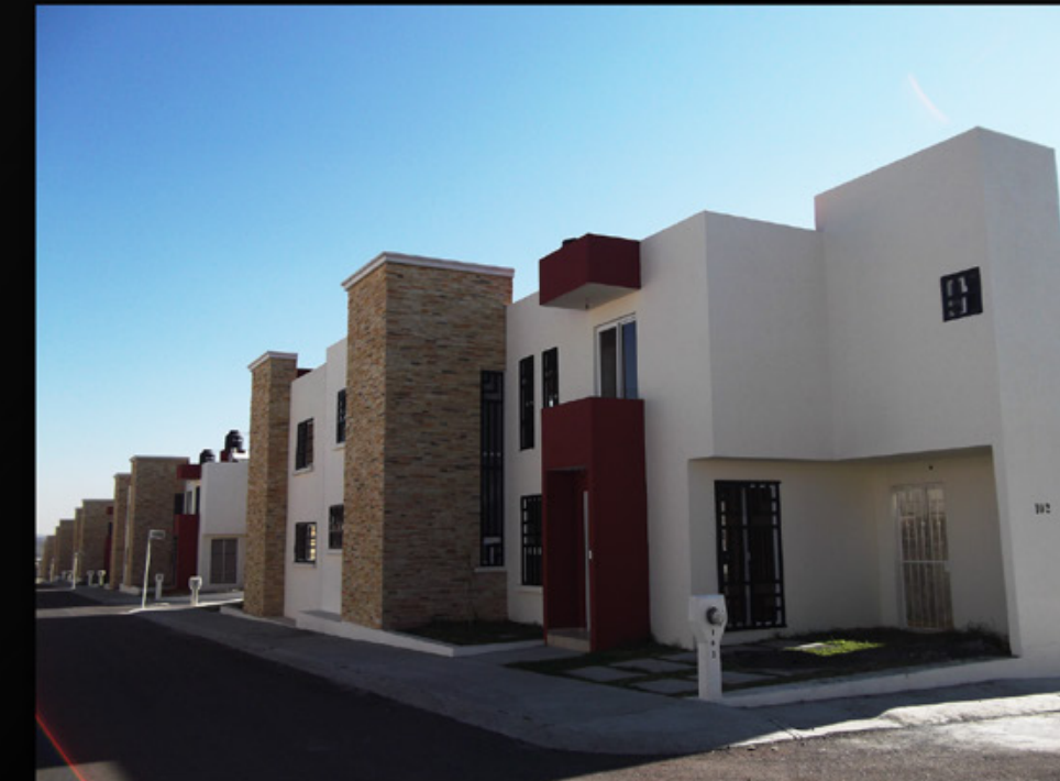
Conjunto Habitacional «La Hacienda». Morelia Michoacán
