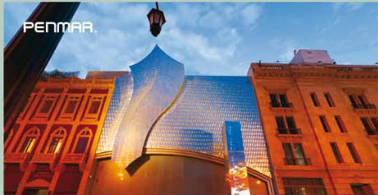
Museo Arocena, 2006 - Fachada 230 m 2 / + 2,000 piezas individuales instaladas.
