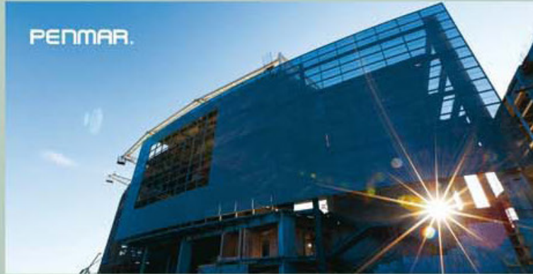
Territorio Santos Modelo, 2009 - Fachada Oeste 3,609 m 2 / + 15,700 piezas individuales instaladas.
