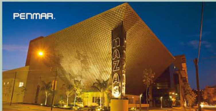
Teatro Nazas, 2004 - Fachada Marquesina y Tramoya 1,615 m 2 / + 25,000 Kg. de Lámina de Zinc.
