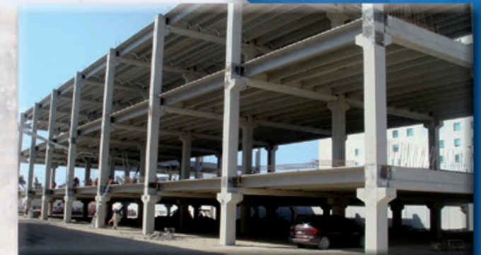
Columnas, Traveses y Losas TT
