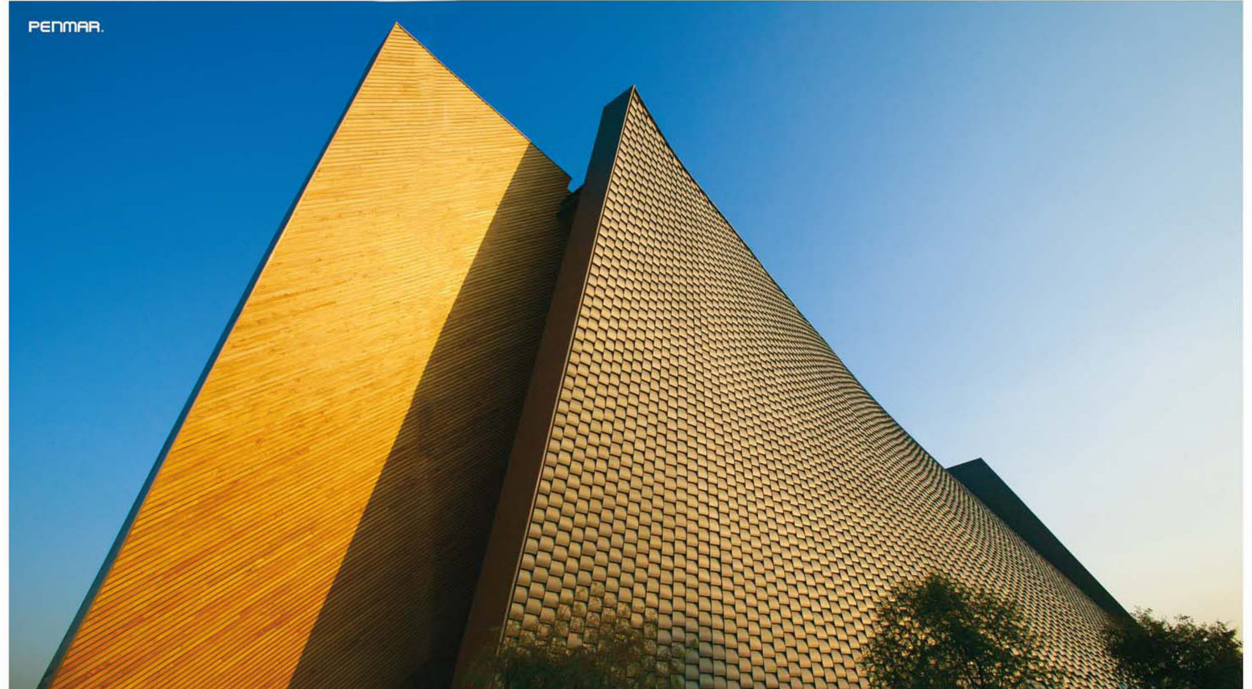
Centro Comunitario Santa Fe, 2007 - Fachada Envolvente +5,000 m 2 / + 40,000 piezas individuales instaladas.
